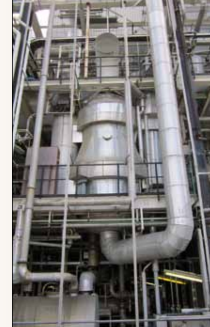
Close-up van de buizenreactor van de DBN-fabriek. In deze reactor bevinden zich 1600 verticale pijpjes van 3 m en een diameter van 2,5 cm, gevuld met katalysator.
